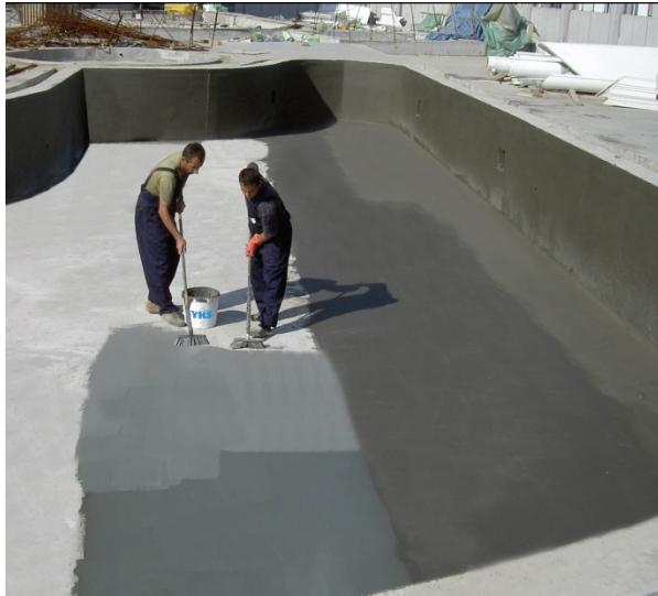
MasterTile WP 666 двухкомпонентная эластичная гидроизоляция на цементной и акриловой основе для защиты бетона и штукатурки на цементной основе.
