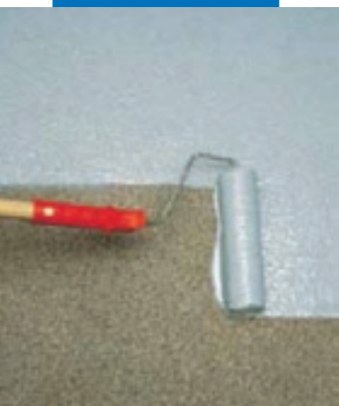
Нанесение Марескоат I 24 валиком
