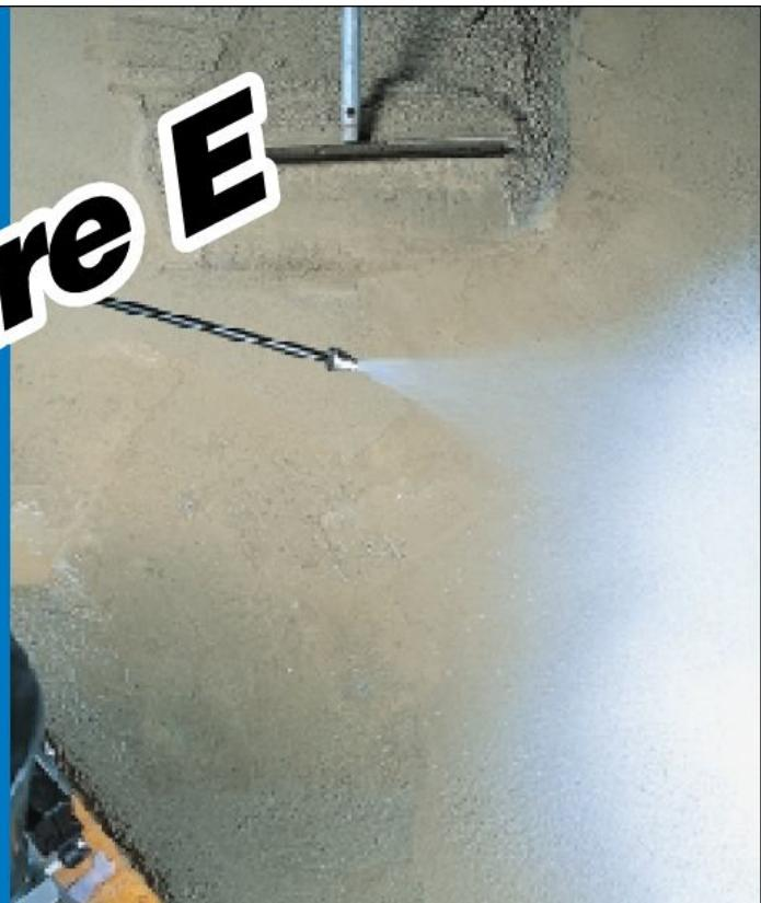
**Водоэмульсионный состав, образующий защитную плёнку для применения на бетонных поверхностях.**
