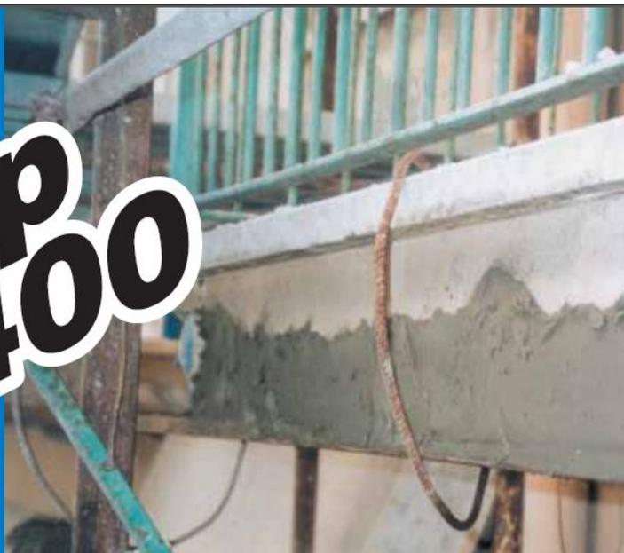
**Быстрохватывающийся тиксотропный раствор с контролируемой усадкой для ремонта поверхностей из железобетона (толщина нанесения 1-40 мм).**
